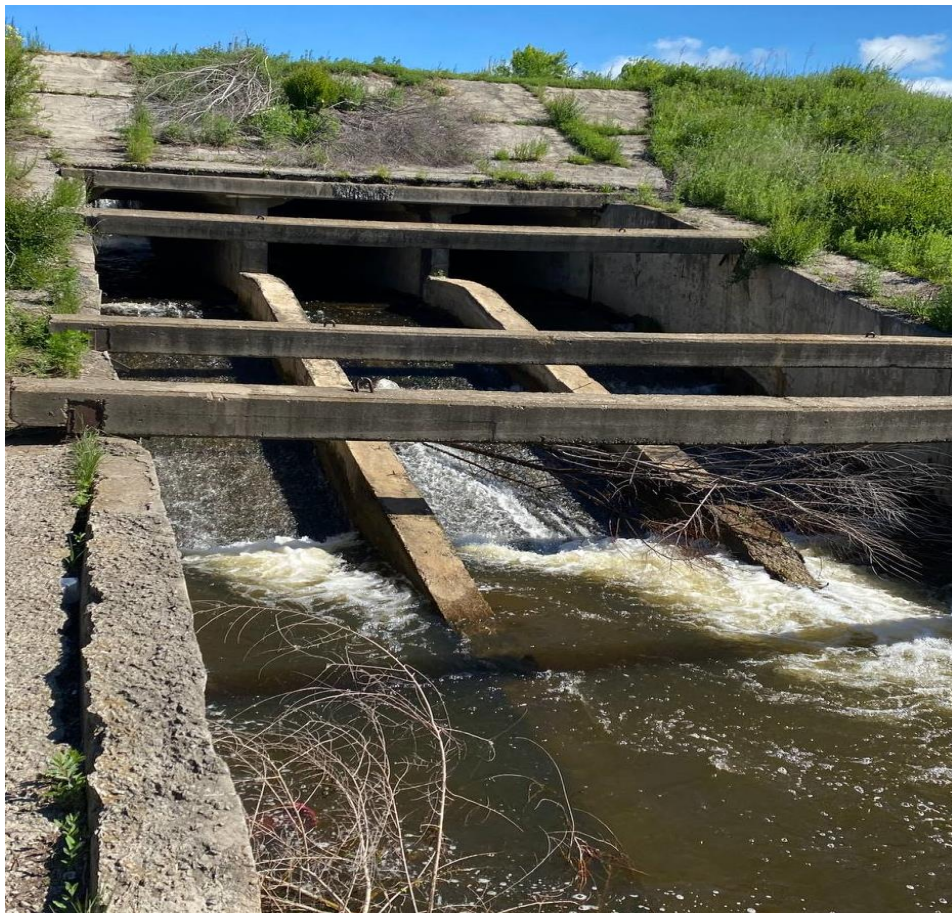
Рисунок 20 – Водосбросное сооружение на Чигиринском водохранилище
